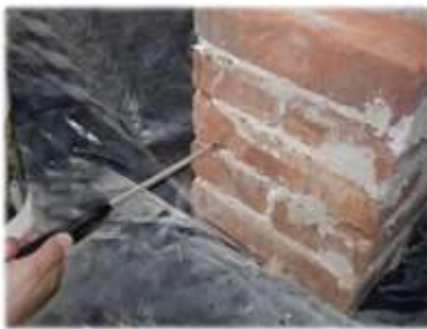
Aplikace pomocí nízkotlakového postřikovače (pumpy)
